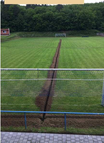
Budování závlahy V-2021
