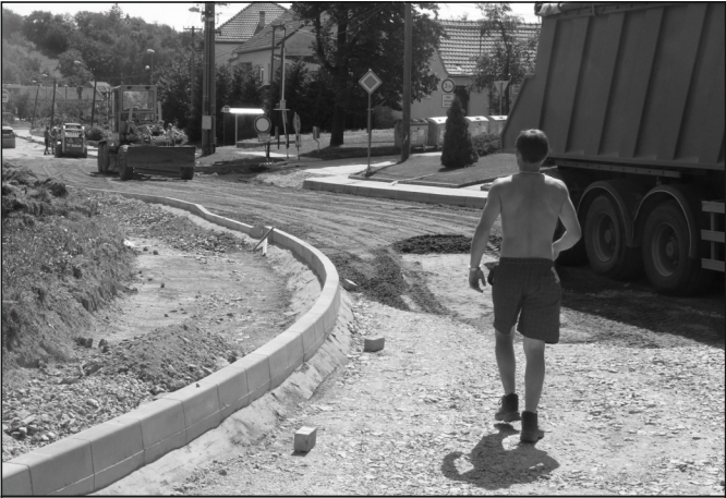
Rekonstrukce průtahu obce je téměř u konce. Silnice je s omezením průjezdná. Foto: Lukáš Tesařík
