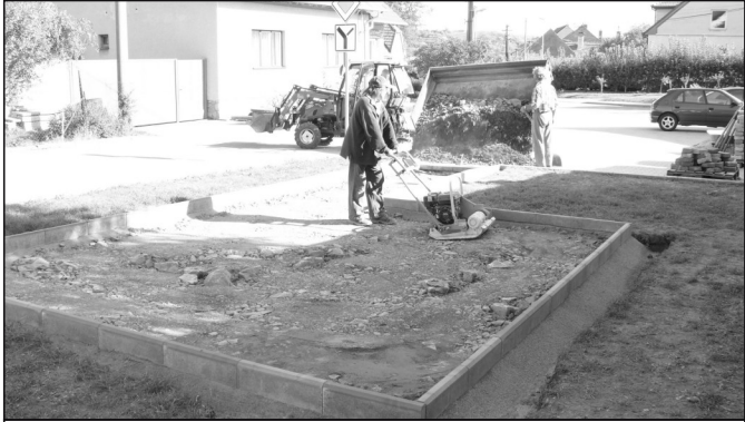
POTÉ, KDY BYLO asanováno stavení vedle domu Kamenských, na začátku Lednice, bylo nutné sutiny odstranit a prostor upravit. Zasloužili se o to pracovníci pro veřejně prospěšnou činnost.
