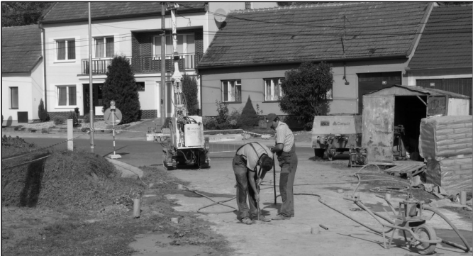
STAVBAŘI ZAČALI S OPRAVOU MOSTU přes potok Vápenka na dolním konci obce. Doprava proto musela být přesměrována; vede po tzv. druhé straně. Most chtějí dokončit do konce letošního listopadu.
