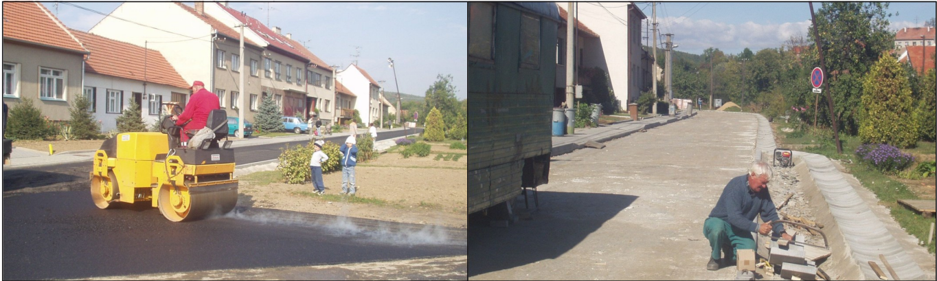
ARCIKNĚZ VÁLKA, by místa, kde se narodil, zřejmě nepoznal. Druhá, tedy též damborská strana, se změnila. Stavení lemuje nová vozovka. Splňuje veškeré parametry kvalitní místní komunikace; byla též odvodněna žlabem, má nové pouliční osvětlení. Při výstavbě mostu na hlavní trase, po ní vede objízďka. Snímky stavení i prací na obnově vozovky pořídil LUKÁŠ TESAŘÍK
