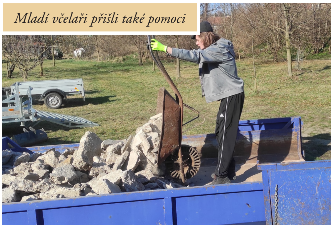
Vyklízení suti v kuchyni včelařského domu
