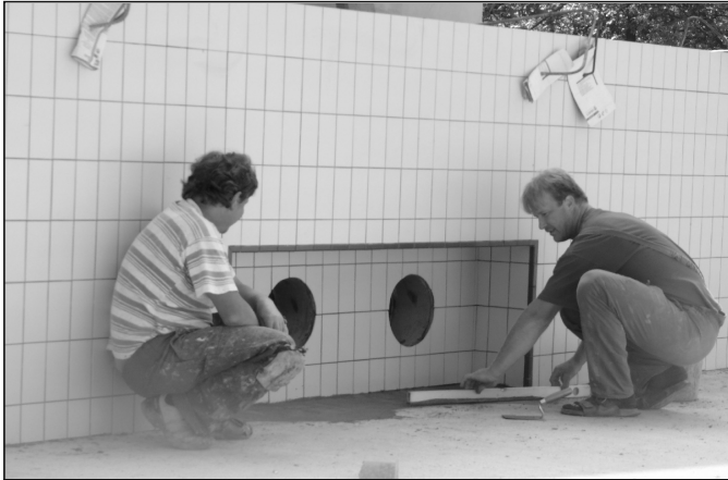
NA BUDOVANÉM koupališti se v polovině června dokončovali poslední úpravy bazénu. Patřilo k němu i světlemodré obložení.
