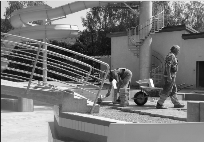
JEŠTĚ V ČERVNU se v novém aquaparku hemžili stavbaři. Bylo nutné dovézt materiál, leccos odklidit. Od poloviny července ale by měl na koupališti začít zkušební provoz. Foto LUKÁŠ TESAŘÍK
